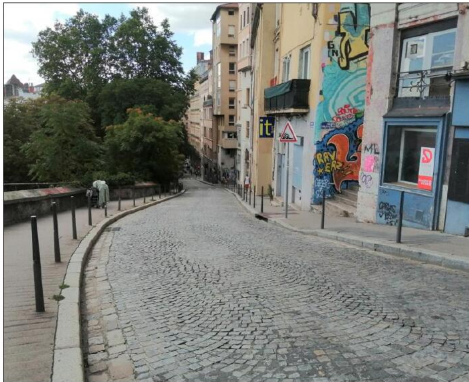
Les travaux d'aménagement en sens unique de la Montée Saint-Sébastien commenceront la deuxième quinzaine de novembre. Photo Progrès/Yves LE FLEM
